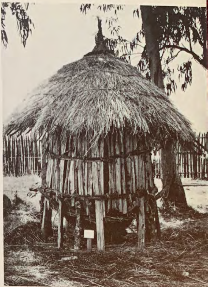
15. Lokal spannmålssilo (Foto H. Linder)
